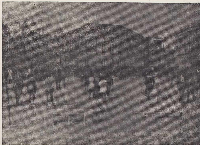
Između kazališta i palače Matiazzi vidi se dvorište sa drvenim tornjem — osmatračnicom
