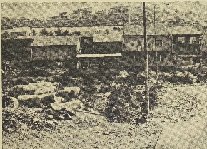
Kanalizacijske cijevi u pripremi
