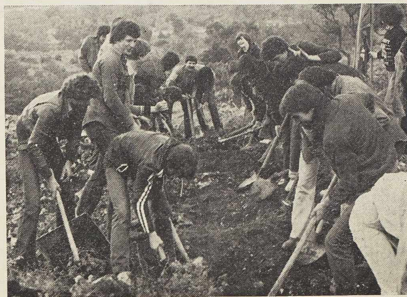
ORB »Šibenski heroji« na izgradnji vodovoda Primošten — Rogoznica
