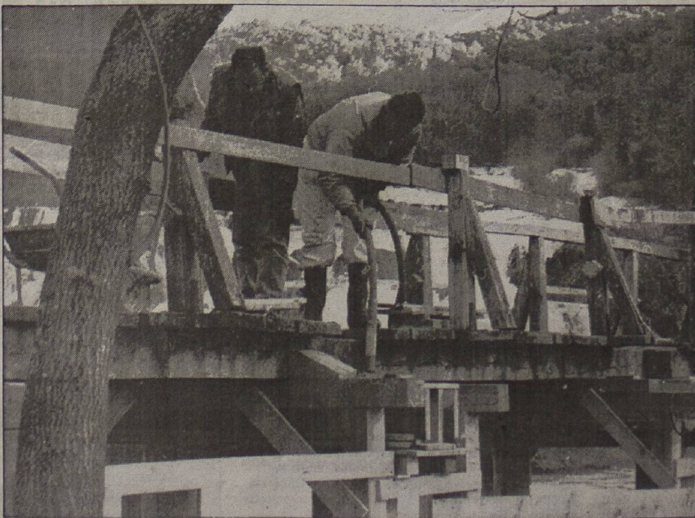
Popravak mosta na Krki
