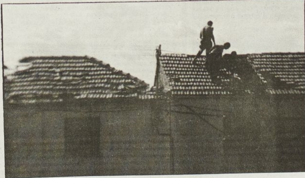
Obnova krovova u Bičinama
